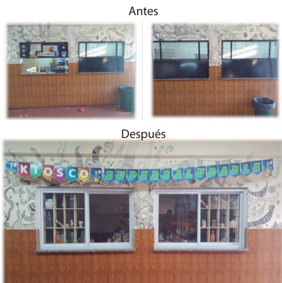
Ilustración 1 - Modificaciones estructurales realizadas en el kiosco.
